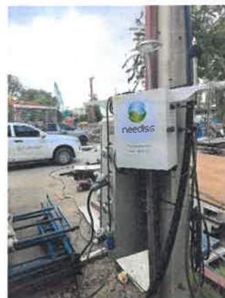
รูปที่ 2-20 แสดงการติดตั้งระบบตรวจสอบค่าความเข้มข้นของ TSP PM 2.5 PM 10 และระดับเสียง แบบการประมวลผลทันที (Real time) ผ่านหน้าจอแสดงผลไว้ด้านหน้าโครงการ
