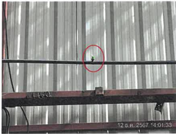
รูปที่ 2-11 แสดงการติดตั้งสปริงเกอร์พ่นน้ำไว้บริเวณโดยรอบรั้วโครงการ
