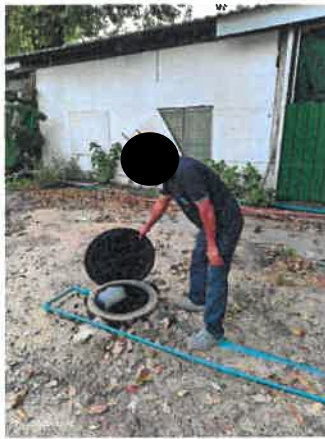
รูปที่ 2-25 แสดงระบบบำบัดน้ำเสียสำเร็จรูปแบบกระโถน-กรองไร้อากาศ และเจ้าหน้าที่ดูแลบำรุงรักษาระบบบำบัดน้ำเสีย
