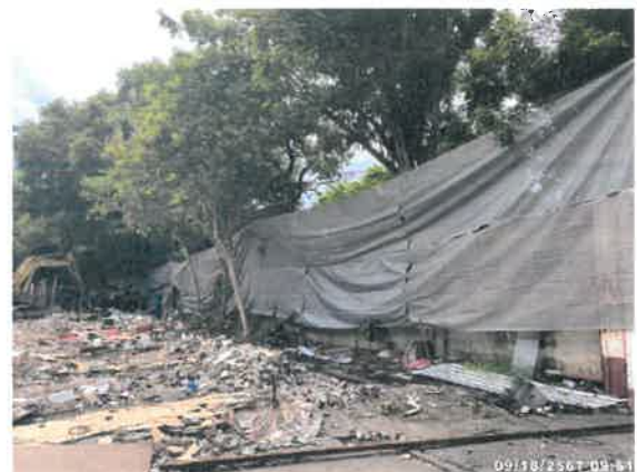
รูปที่ 2-4 แสดงการติดตั้งผ้าใบป้องกันฝุ่นละอองชนิดป้องกันไฟลาม (Mesh Sheet)
