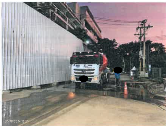
รูปที่ 2-13 แสดงทางวิ่งคอนกรีต พื้นที่สำหรับล้างล้อรถ และเจ้าหน้าที่ทำความสะอาดล้อรถบรรทุกดินและวัสดุก่อสร้าง
