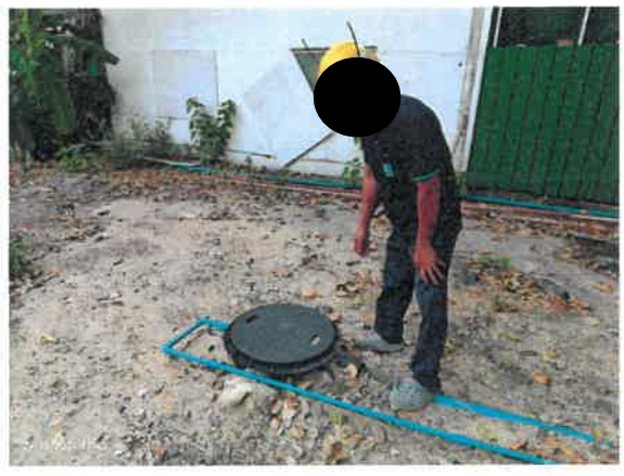
รูปที่ 2-25 แสดงระบบบำบัดน้ำเสียสำเร็จรูปแบบกระโถน-กรองไร้อากาศ และเจ้าหน้าที่ดูแลบำรุงรักษาระบบบำบัดน้ำเสีย
