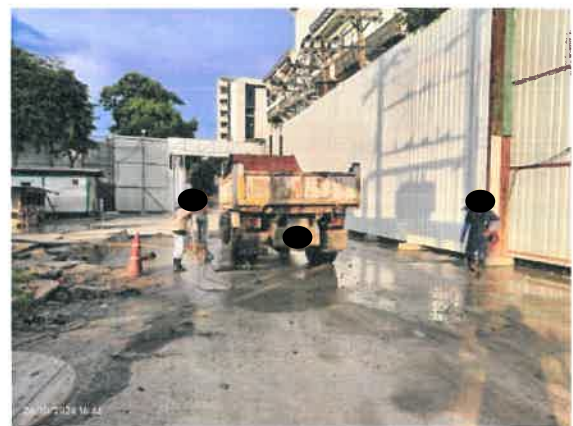
รูปที่ 2-13 แสดงทางวิ่งคอนกรีต พื้นที่สำหรับล้างล้อรถ และเจ้าหน้าที่ทำความสะอาดล้อรถบรรทุกดินและวัสดุก่อสร้าง
