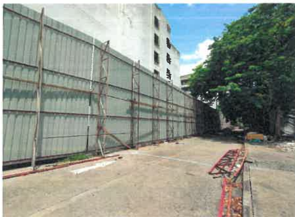
รูปที่ 2-2 แสดงรั้วทึบเมทัลชีท (Metal Sheet) ความสูง 6 เมตร
