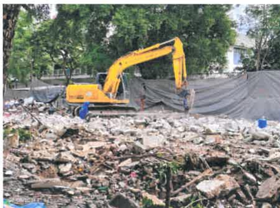
รูปที่ 2-14 แสดงรถแบคโฮที่ติดตั้งหัวหนีบและหัวเจาะคอนกรีต (Hydraulic Crusher Excavator)
