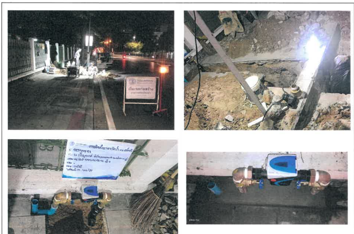
รูปที่ 2-28 แสดงการติดตั้งมิเตอร์รับน้ำและระบบท่อประปาเชื่อมต่อกับท่อประปาของสำนักงานประปานครหลวง
