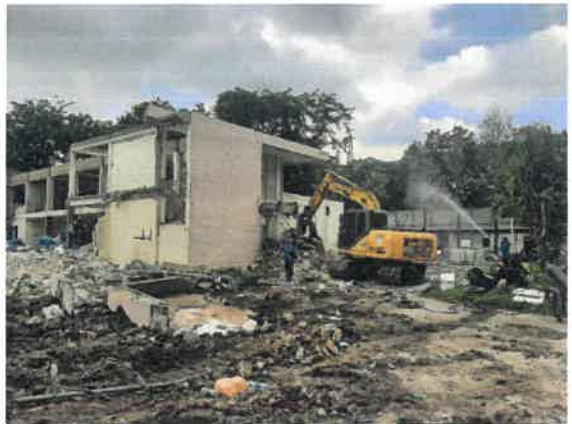
รูปที่ 2-6 แสดงเจ้าหน้าที่ฉีดน้ำลดฝุ่นละออง ในช่วงที่มีการทุบ รื้อ หรือตัดคอนกรีต
