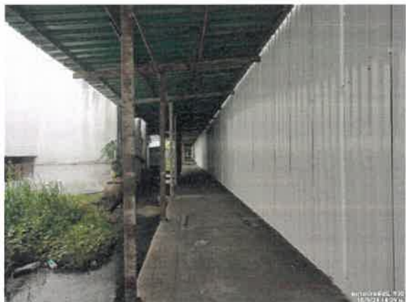
รูปที่ 2-2 แสดงรั้วทึบเมทัลชีท (Metal Sheet) ความสูง 6 เมตร
