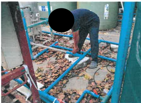
รูปที่ 2-31 แสดงเจ้าหน้าที่ตรวจสอบจุดรั่วซึมของระบบน้ำประปาทั้งในพื้นที่ก่อสร้าง และบ้านพักคนงาน
